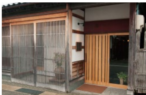
輪島塗に従事していた塗師屋の建物を利用
