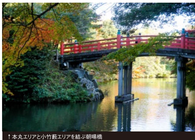
↑本丸エリアと小竹藪エリアを結ぶ朝陽橋
